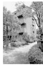
遊歩道（住宅敷地内）
